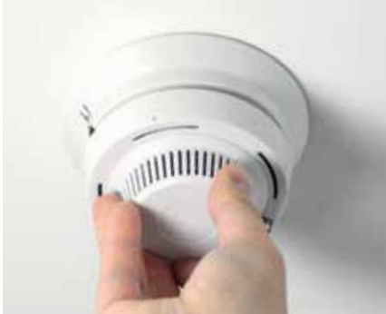
► Der Rauchmelder sollte stets in der Mitte des Raumes angebracht werden.
